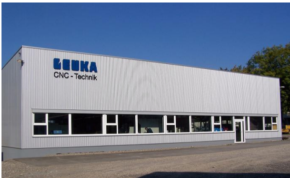
Neuer Hallenanbau Fa. LEUKA in Weiler-Simmerberg
